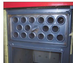
Kedel vist med afmonteret renslem til rørør
