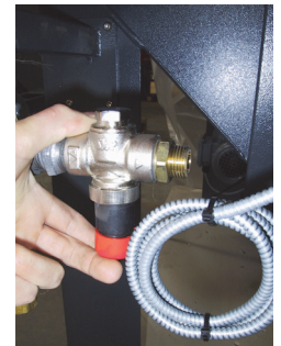
Sprinklerventil med afmonteret slange
